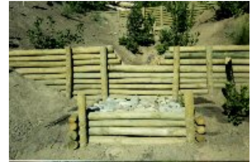
Diques de Postes
