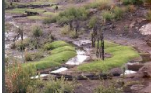
Zanja de Infiltración
